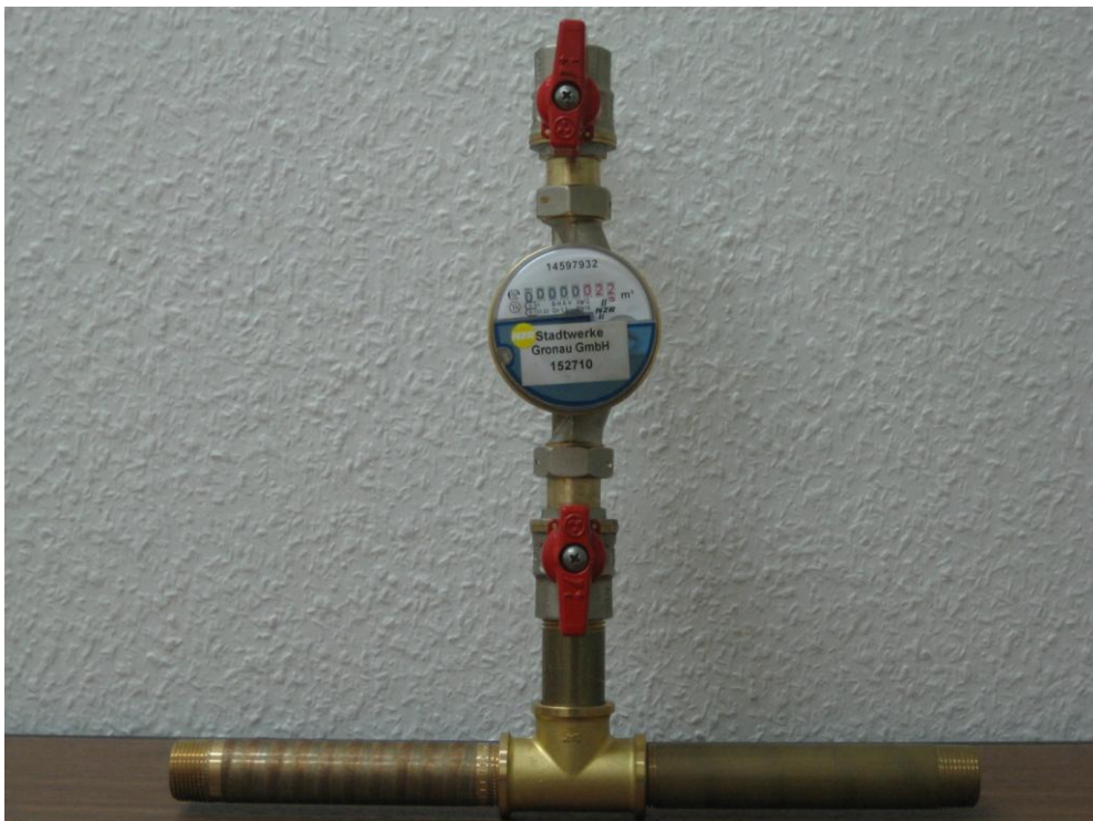
Kaltwasserzähler am Verteilerstamm mit Absperreinrichtung vor und hinter jedem Zähler.
