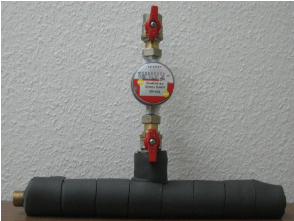
Warmwasserzähler am Verteilerstamm mit Absperreinrichtung vor und hinter jedem Zähler.
