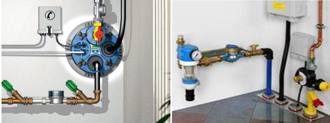
Abb. 5 und 5a: Beispiele einer Hausanschlusswand
